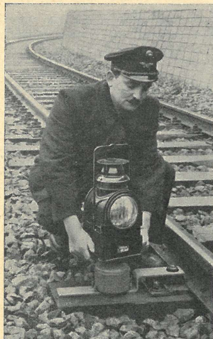
Abb. 9 Lösen der Propan-Signallaterne von der Gasflasche
