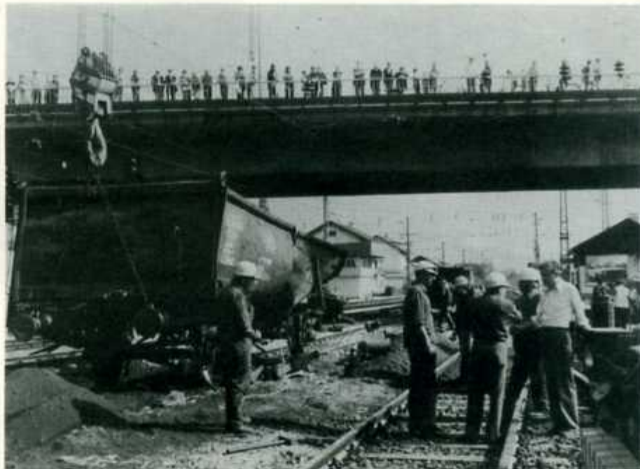
Einsatzleitung anlässlich der Entgleisung des Z 77712 im Bf Bludenz am 20. 9. 1980
