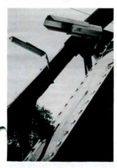
Während des Probebetriebes werden Messungen im Hinblick auf gegenseitige Beeinflussungen, Störungen durch die Fahrleitung usw. durchgeführt und die Tauglichkeit der neuen Einrichtung zur Zugschlußfeststellung vor allem bei den verschiedensten Witterungs- und Lichtverhältnissen getestet. Eine endgültige Aussage über die betrieblichen Erkenntnisse der ggst. TV-Anlage kann erst nach Abschluß eines ca. 1jährigen Probebetriebes getroffen werden.
