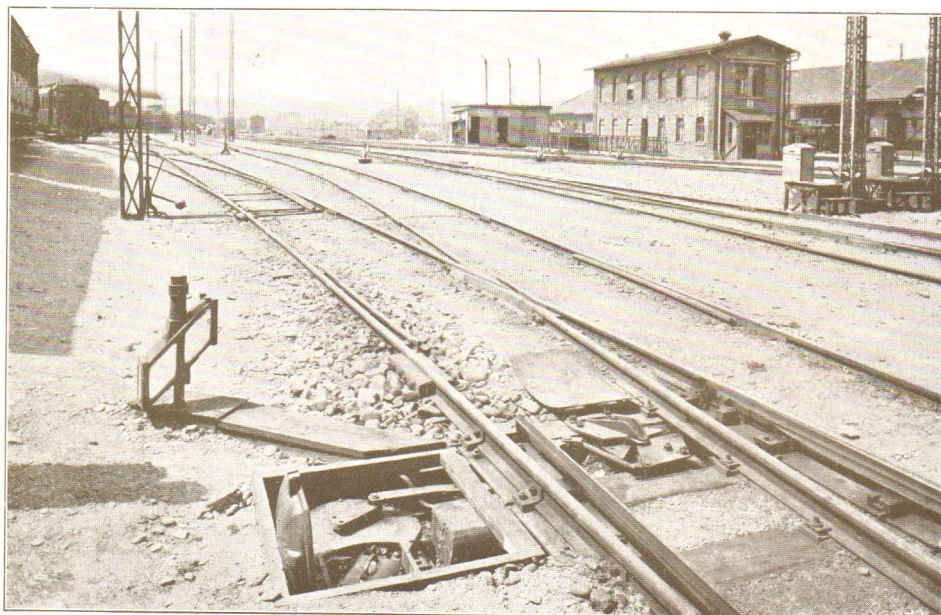
Abstellbahnhof Dresden mit elektrischem Stellwerk.
