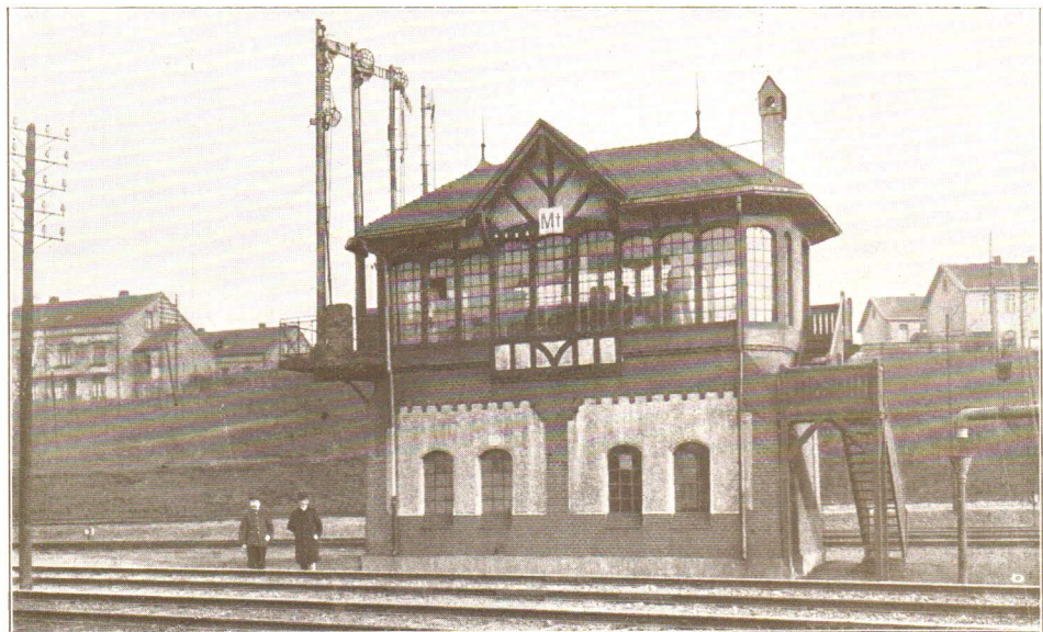
Elektrisches Stellwerk — Bahnhof Steele-Nord.
